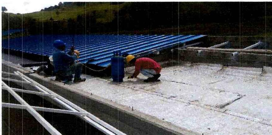
SE HACE LA INSTALACIÓN DEL MANTO ASFÁLTICO CON FOIL DE ALUMINIO
