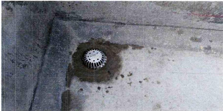
**SE HACE INSTALACION DE BAJANTES DE 4" Y SE INSTALAN LAS REJILLAS EN LA CUBIERTA**
