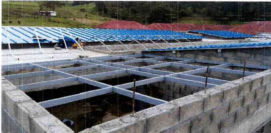
**SE HACE LA ESTRUCTURA DE LA CUBIERTA DEL POLICARBONATO UNA PENDIENTE**
