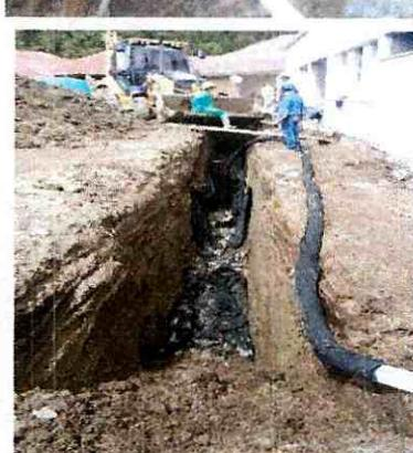
SE INSTALA EL GEOTEXTIL PARA EL FILTRO Y SE HACE LA INSTALACION
